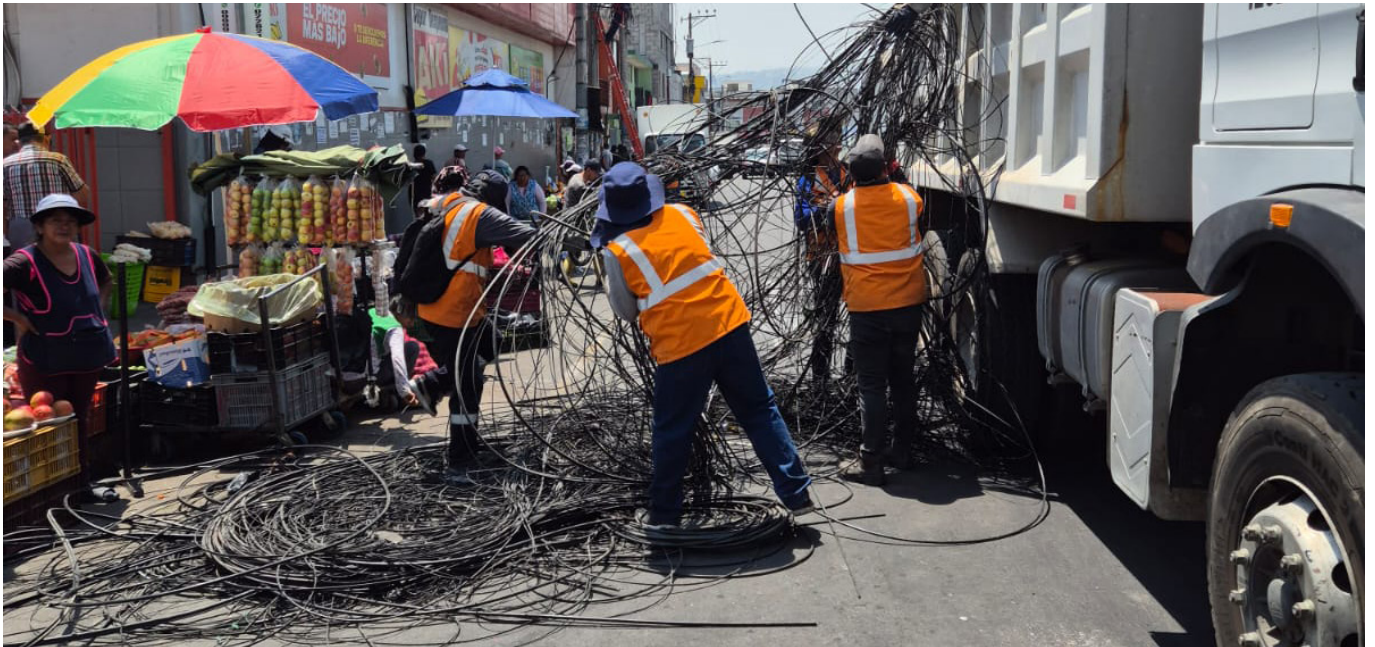
Retiro de cables en la Calle Rodrigo de Chávez. Fuente: SHOT, 2024.
