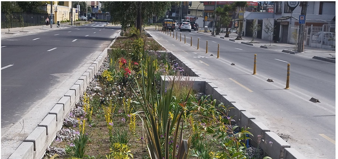
SUDS en la Avenida Juan de Ascaray, áreas de biorretención. Fuente: SHOT, 2024.
